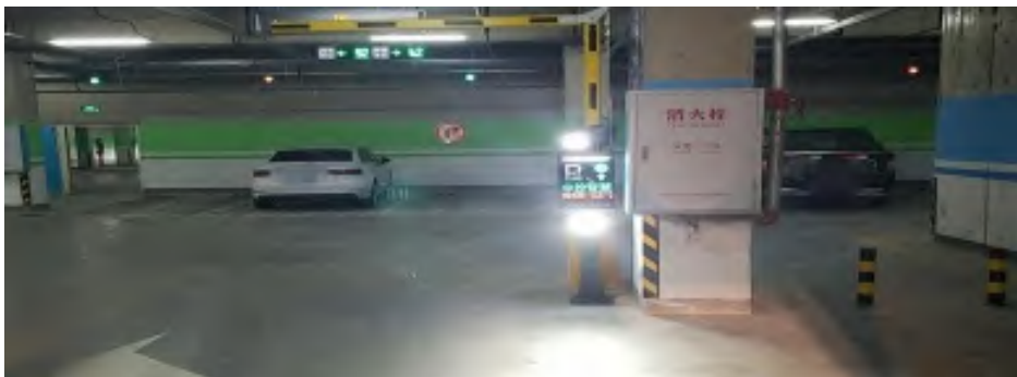
某小区地下停车场
