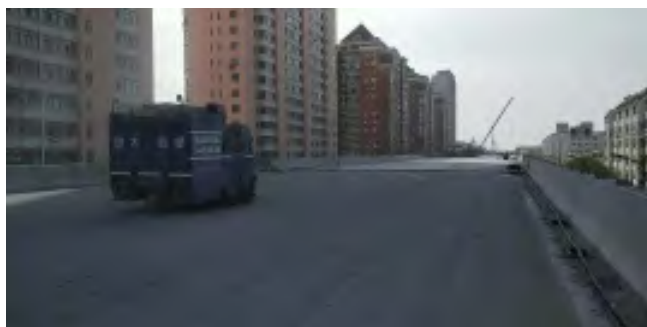
城乡路高架桥 - 桥面沥青
