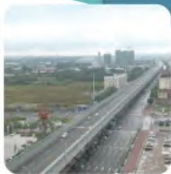
城乡路高架桥
