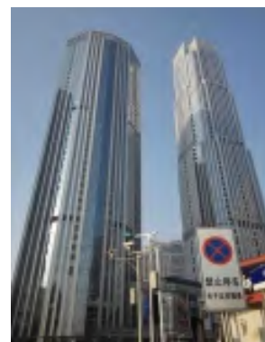
天津凯德国贸大厦一座玻璃幕墙钢构架指定供应商
