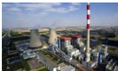
华电邹县电厂四期整体加固
