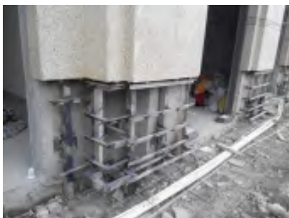
天津文化中心历史馆工程，建筑面积为76352平方米，其中幕墙面积约23100平方米。建筑标高171.7m
