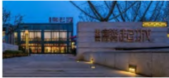
麟起城郑州美景二期二号院外墙保温及外墙涂料施工
