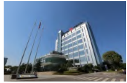
中国中车株洲所净化、除湿项目
