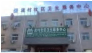
北京市昌平区流村社区卫生服务中心燃煤锅炉改电取暖项目
