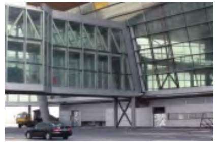
首都机场 T3B 登机桥工程
