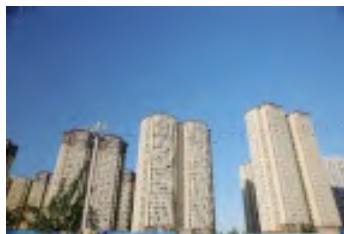
工程名称: 焦化厂棚户区改造 承建单位: 新兴保信 建设单位: 北京市保障性住房建设投资中心 工程地址: 朝阳区·垡头
