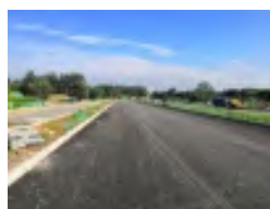
再生无机混合料在北京朝阳孙河北路应用
