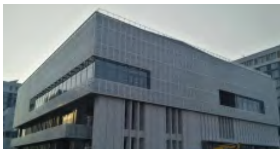
项目名称：北京东方航空公司 1, 2, 3, 4 号公寓楼 合作单位：浙江欣世纪建筑系统科技有限公司
