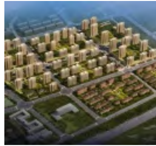
项目名称: 天津“一号工程”全运村项目 产品服务: 铝合金门窗、百叶 签约时间: 2017 年
