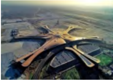
2017年北京新机场飞行区项目，采用我公司生产的B型轻集料混凝土 13000 立方用于屋面找坡
