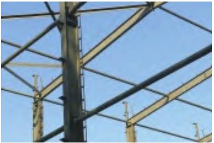
中国石化昌平临氢厂房钢结构
