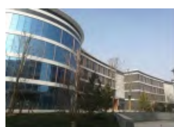
北京大兴金隅物流园
