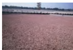
再生净水滤料在永定河修复工程中应用
