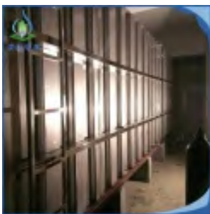
不锈钢筋板水箱
