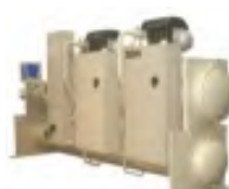
磁悬浮离心式冷水机组
