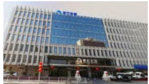
申万宏源证券总部大楼净化项目
