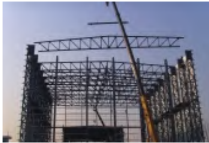
中国电力科学研究院电力电子实验室钢结构工程
