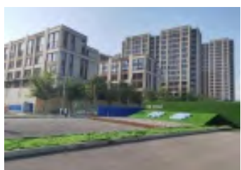
工程名称: 长阳镇 02 街区 承建单位: 中建三局集团 建设单位: 北京稻香四季房地产公司 工程地址: 房山区·长阳镇
