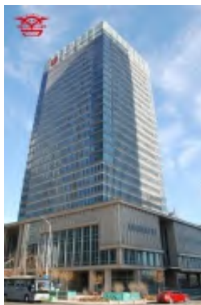
天津燕赵大厦屋面卷材防水工程
