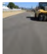
无机混合料在北京怀柔杨雁路应用
