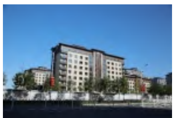
工程名称: 潞城镇棚户区改造 承建单位: 北京城建集团、北京建工集团 建设单位: 北京市保障性住房建设投资中心 工程地址: 通州区·潞城镇
