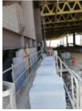
项目名称：济南西部会展中心项目 合作单位：中建八局
