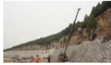
曲阜尼山水库加固项目
