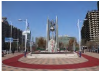
天津市河西区危改广场提升改造工程
