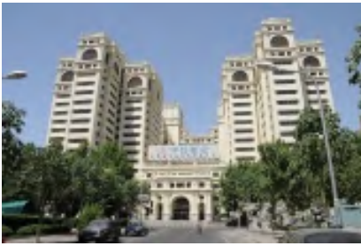
中信银行股份有限公司整体楼宇净化项目
