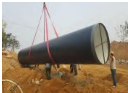
大口径螺旋钢管外包涂层用于中石化工厂项目，用量1130米
