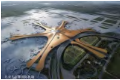
北京大兴新国际机场
